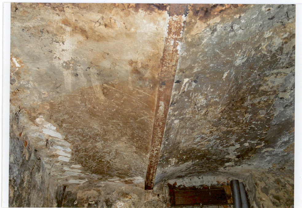
13. Piwnice – fragment stropu odcinkowego (tzw. strop Kleina).
