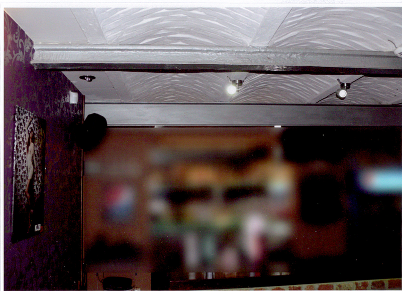
17. Piwnica – strop Kleina
