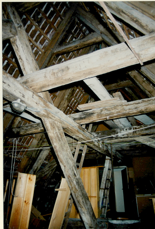
Więźba dachowa z II ćw. XIX w. Trakt przedni: konstrukcja krokwiowo- jętkowa, w ujęciu ku wschodowi.
