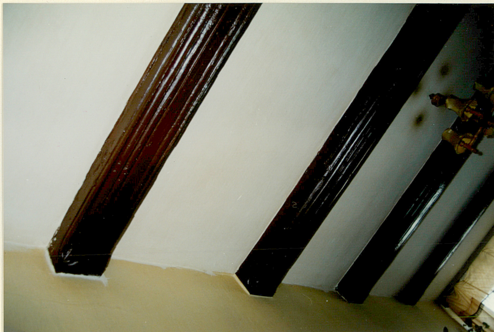
Wnętrze w trakcie tylnym II-go piętra. XVI-wieczne profilowane belki stropowe podwieszone do stropu masywnego.
