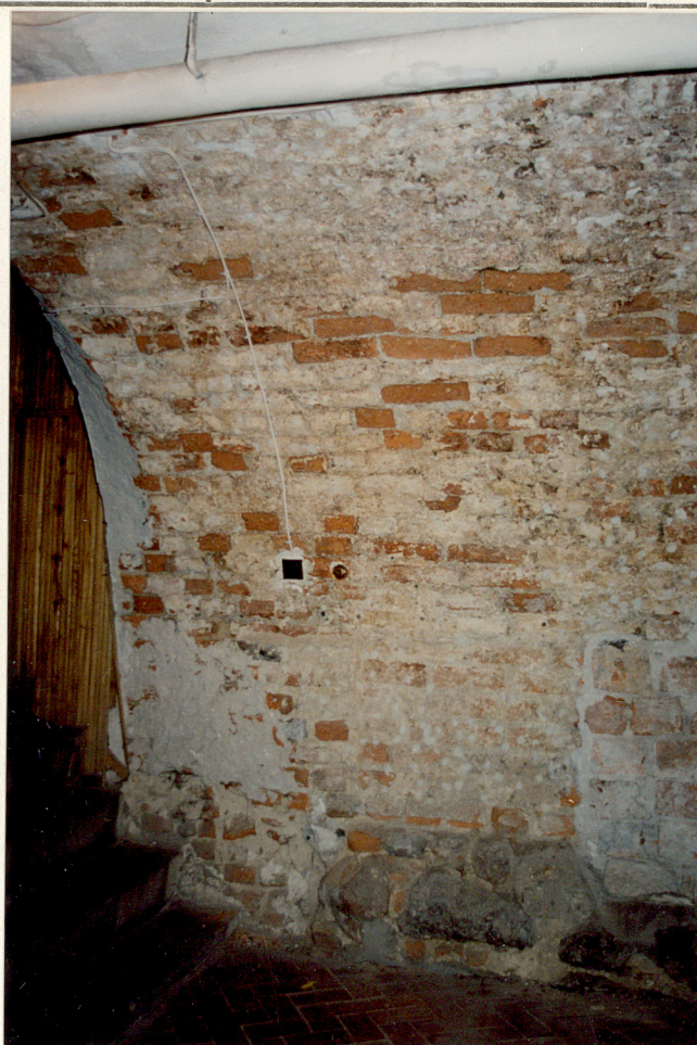
Piwnice - fragment gotyckiego muru pld. w trakcie frontowym. Sklepienia z okresu nowożytnego.
