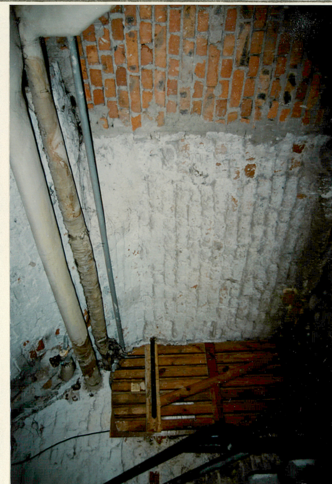
Piwnica w trakcie tylnym budynku frontowego - ujęcie w kierunku naroża pld.-wsch. Dolna partia muru gotycka; sklepienia przebu- dowane w XVIII wieku. Z prawej - zamurowany otwór przejściowy do nr 34.
