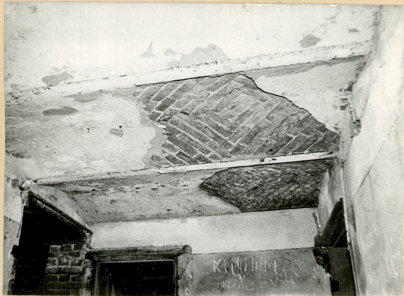
Strop odcinkowy w partii parteru
