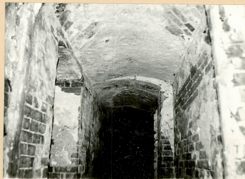
Stropy odcinkowe w piwnicach:
