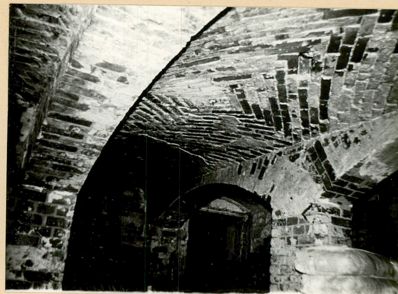
Stropy odcinkowe w piwnicach:
