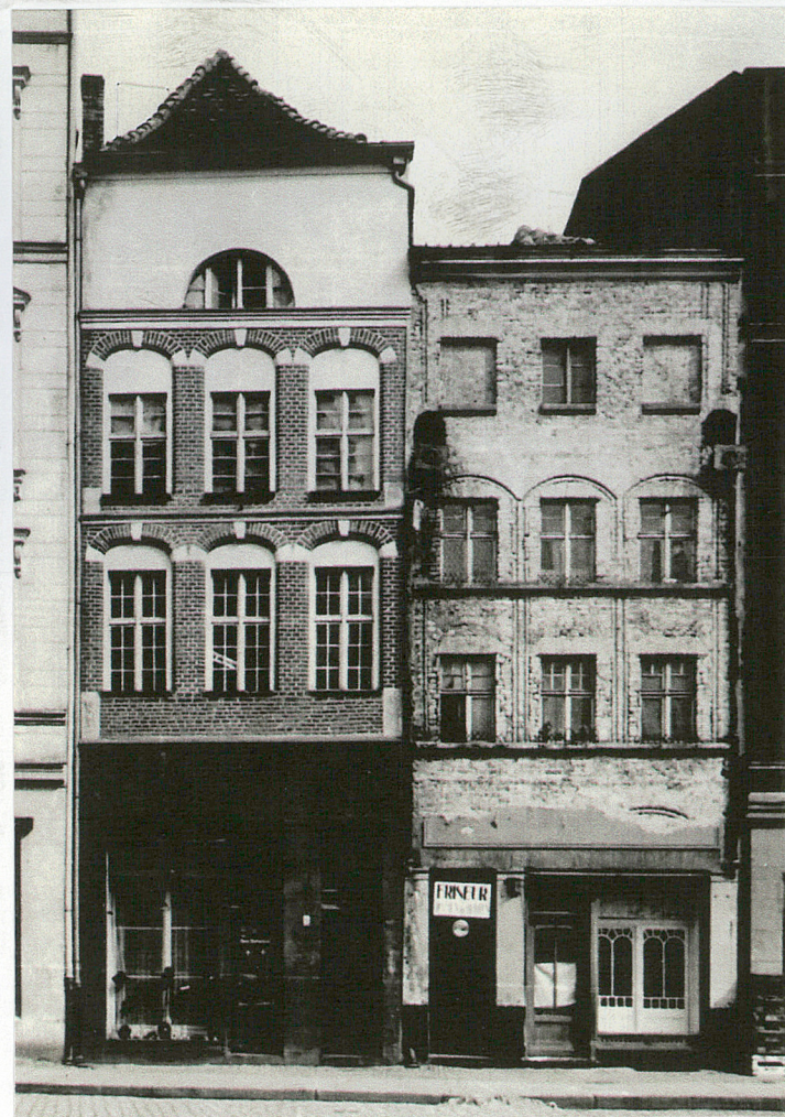
Fotografia b.d. - stan po odbiciu tynków
