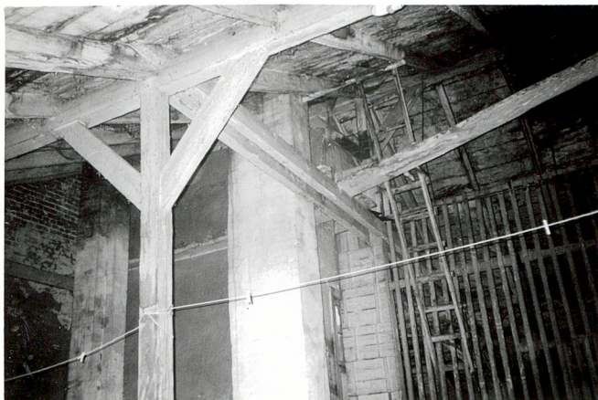
Strych budynku głównego, fragment więźby dachowej
