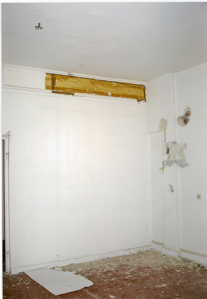
24. I piętro. Trakt frontowy. Podciąg. Z prawej strony (ściana zach.) widoczny zamurowany otwór drzwiowy.
