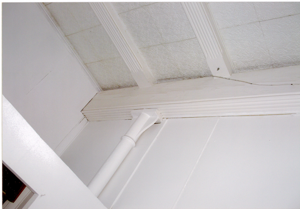
12. Parter. Trakt frontowy. Słup podpierający podciąg, wprowadzony wtórnie.
