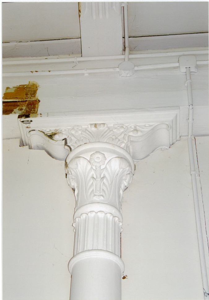
14. Parter. Trakt tylny. Głowica kompozytowa słupa podpierającego podciąg.
