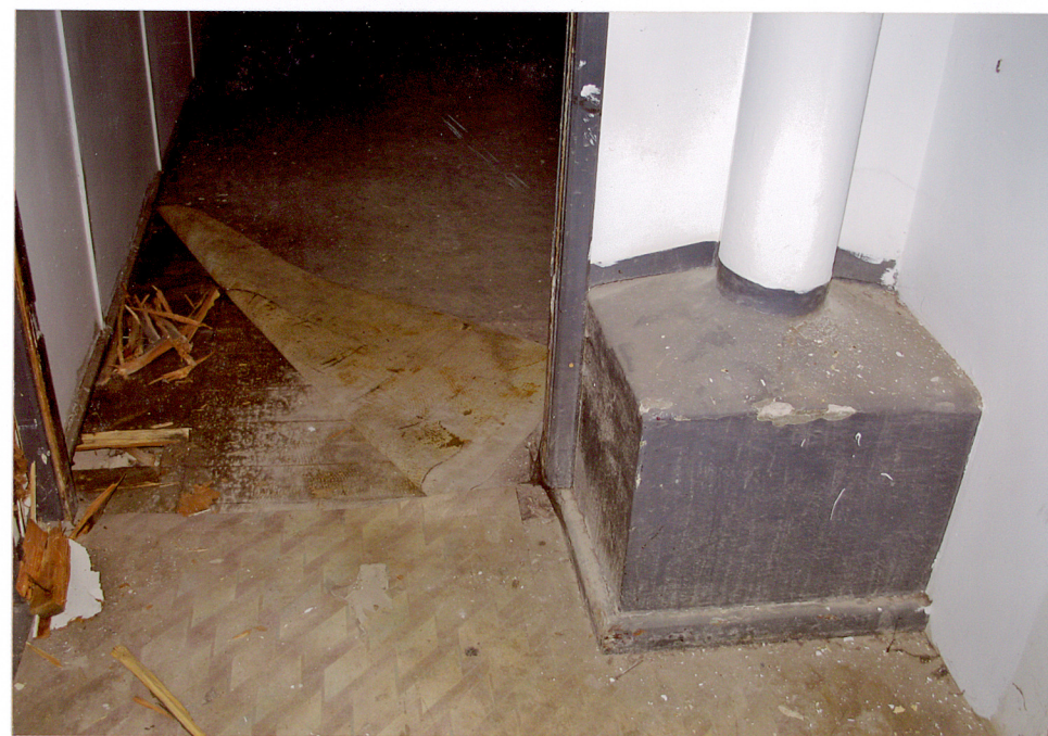
18. Parter. Trakt frontowy. Fragment słupa podpierającego podciąg.
