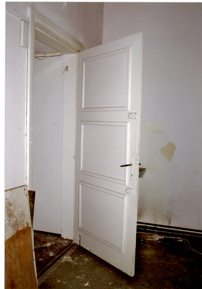
21. Parter. Trakt tylny. Otwór drzwiowy w miejscu pierwotnego okna.
