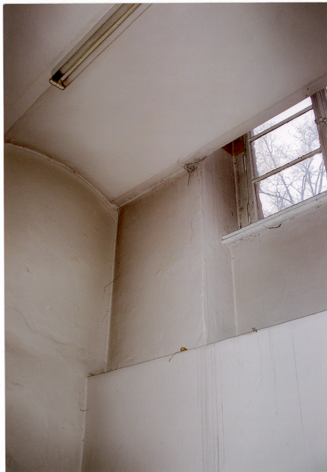
30. Klatka schodowa. Fragment stropu odcinkowego.
