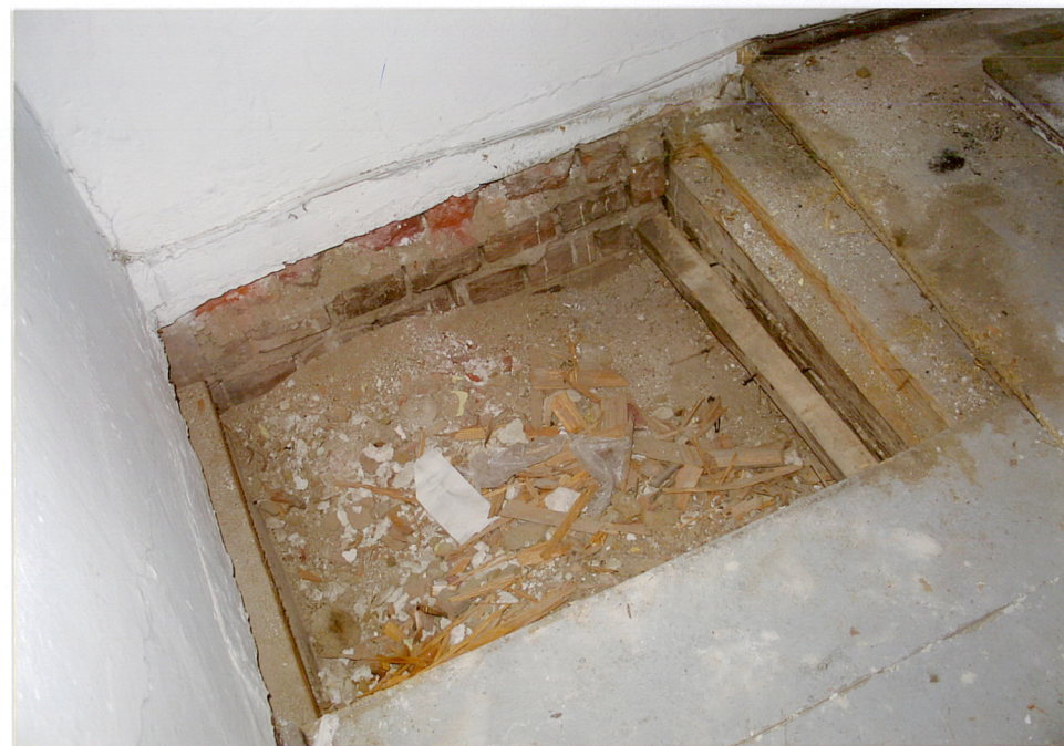
28. II piętro. Trakt frontowy. Odkrywka konstrukcyjna stropu między I i II piętrem.
