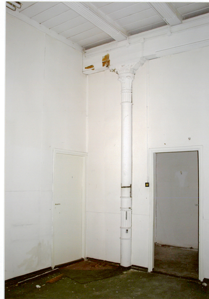
16. Parter. Trakt tylny. Słup podpierający podciąg (pierwotny).
