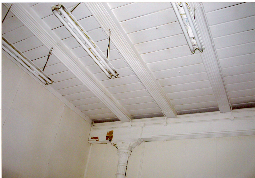
17. Parter. Trakt tylny. Strop z belek profilowanych.
