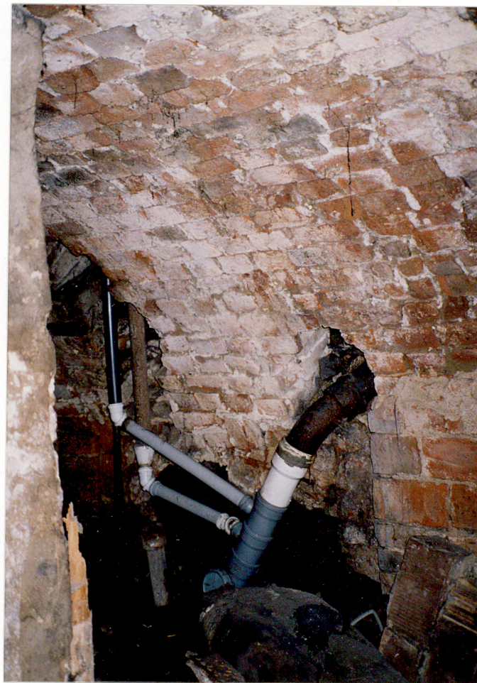
23. Sklepienie kolebkowe w piwnicy.
