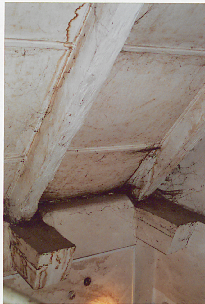
Ucięte belki stropowe, widok w kierunku północnym
