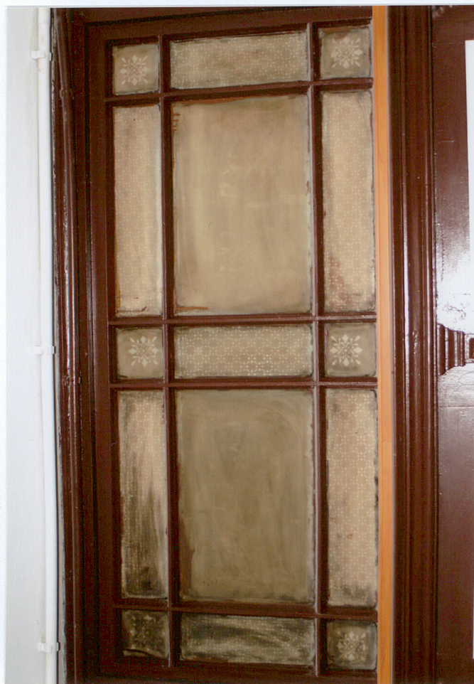
Fot. 16. Nadświetle stolarki drzwiowej lokalu pierwszego piętra; szkło trawione.
