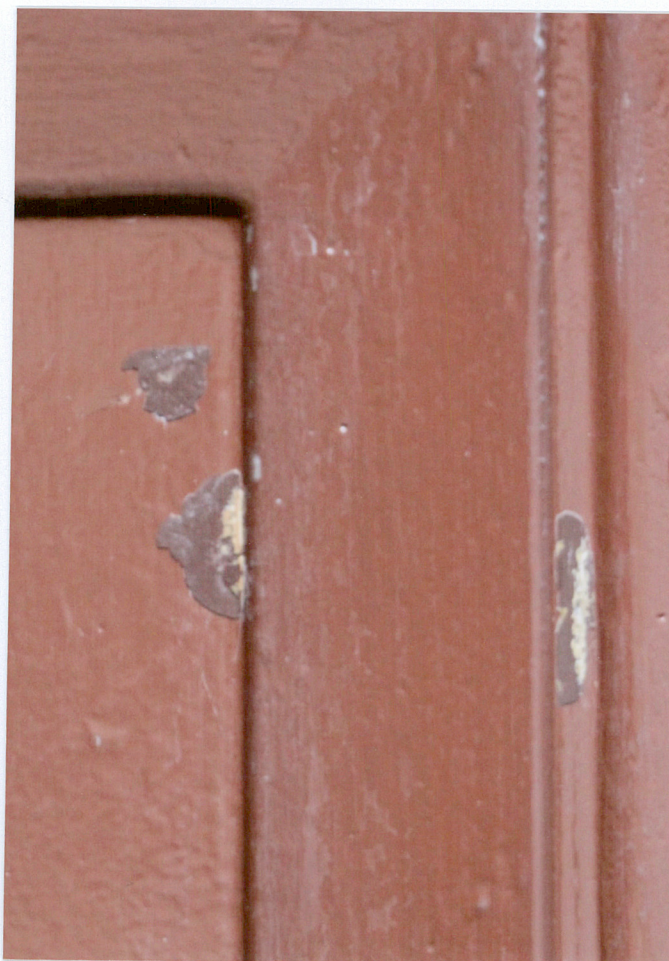
Fot. 19. Samoczynna odkrywka na stolarce drzwiowej półpiętra ukazująca stratygrafię warstw powłok malarskich..
