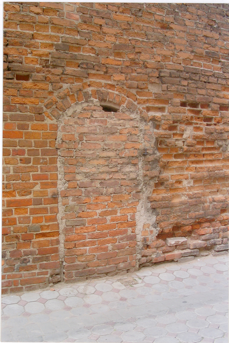
7. Zamurowany otwór wejściowy w skrajnej lewej osi elewacji głównej wsch.
