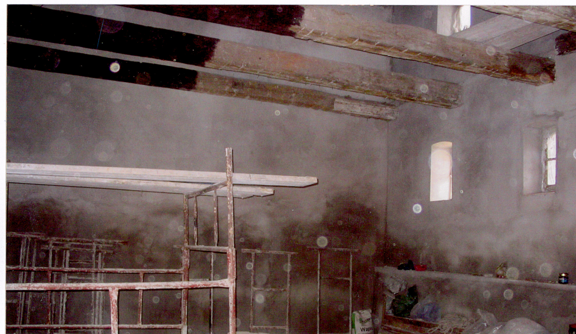
11. Widok otworów okiennych w murze zachodnim w kierunku narożnika pd.zach. Belki stropowe bez pułapu osadzone są poniżej belek więzaryowych.
