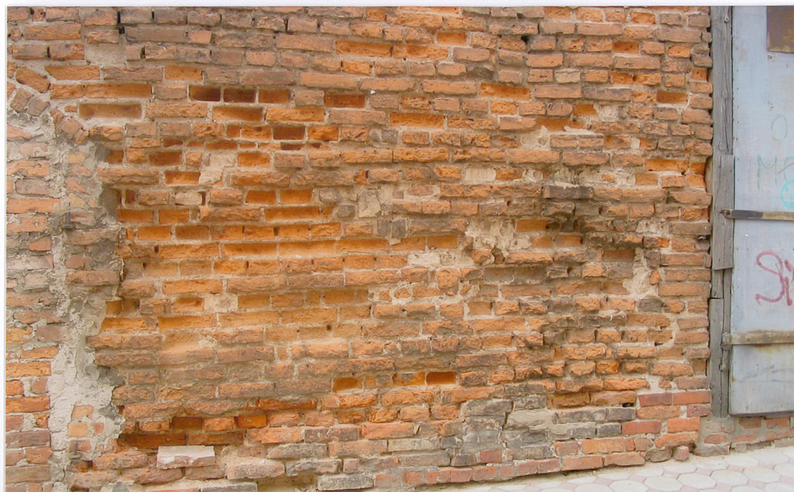
9. Zbliżenie zniszczeń lica muru elewacji frontowej spichrza .
