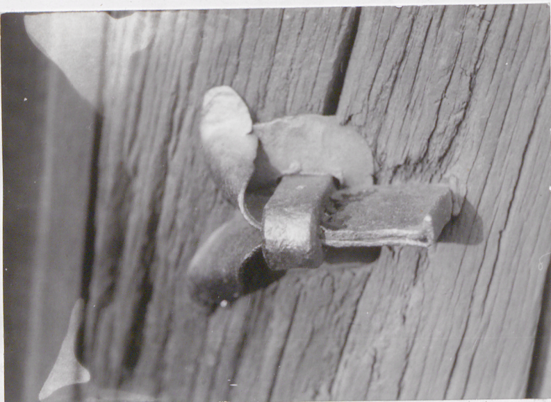
32. Zakończenie kotwy, elewacja południowa, nawa
