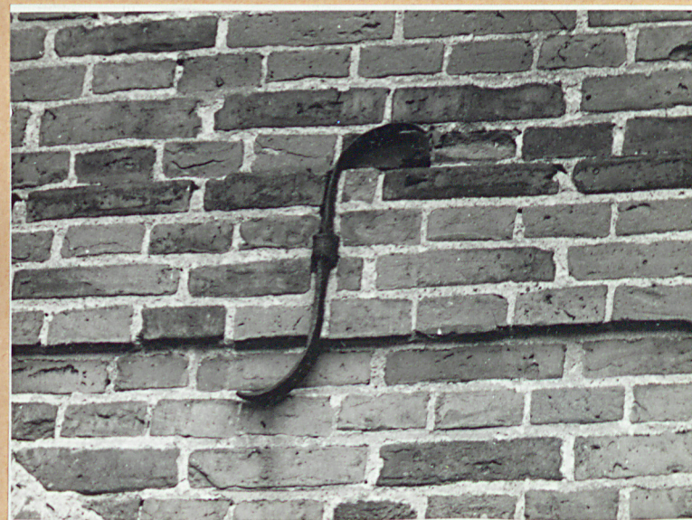
Kotwa metalowa na elewacji frontowej
