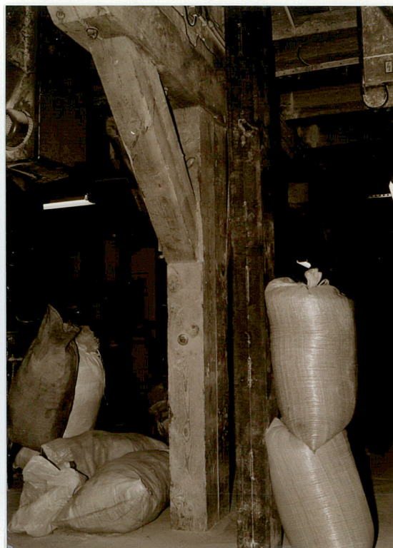
13. Słup podtrzymujący podciąg stropu
