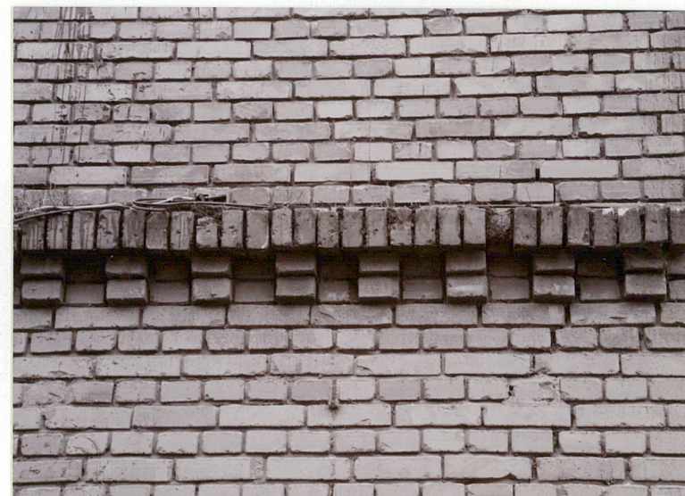
16. Gzyms ceglany oddzielający parter od piętra
