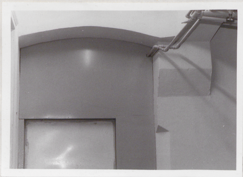
Łuk odcinkowy, odciążający otwór drzwiowy.
