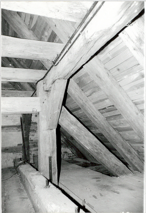
24. Gniazdo konstrukcyjne wieszara nad nawą, nadciągi stropu i wzmocnienie stolca.
