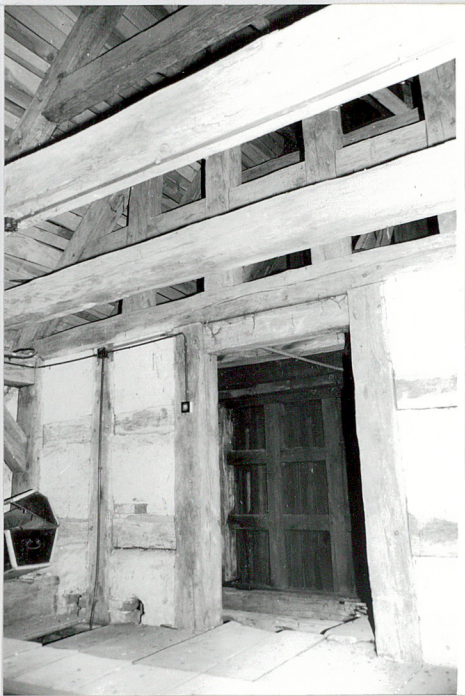
26. Więźba dachu nad zach. częścią nawy, konstrukcja ścian między nawą i wieżą.
