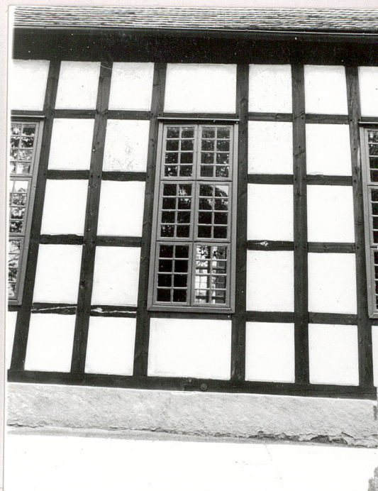
10. Konstrukcja ściany nawy i okno.
