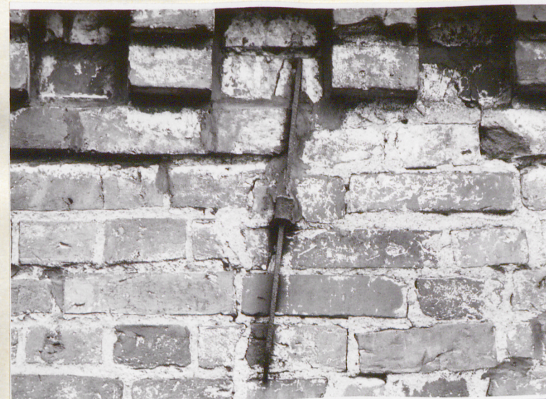
Kotwa metalowa na elewacji północnej
