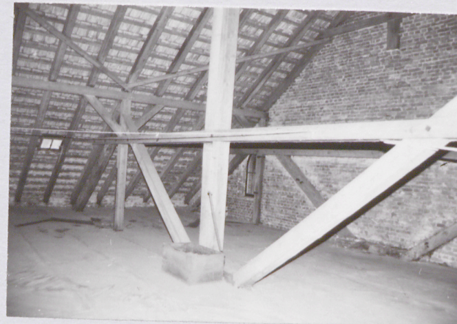
23. poddasze, konstrukcja więźby dachowej
