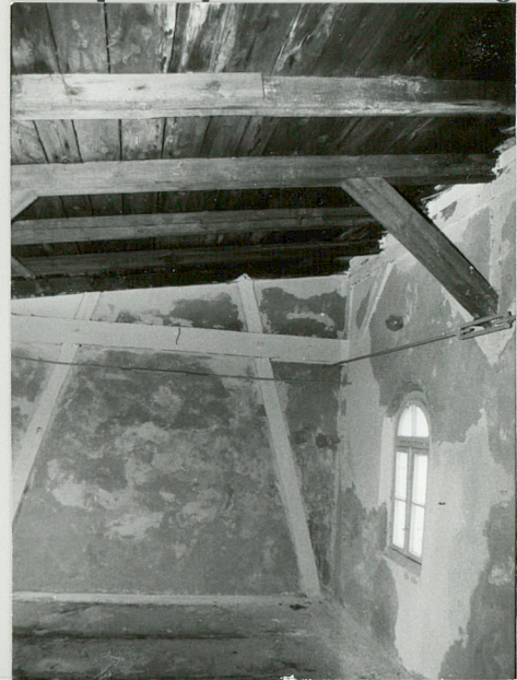
49.Piętro- konstrukcja ścian i stropu w partii wieżowej
