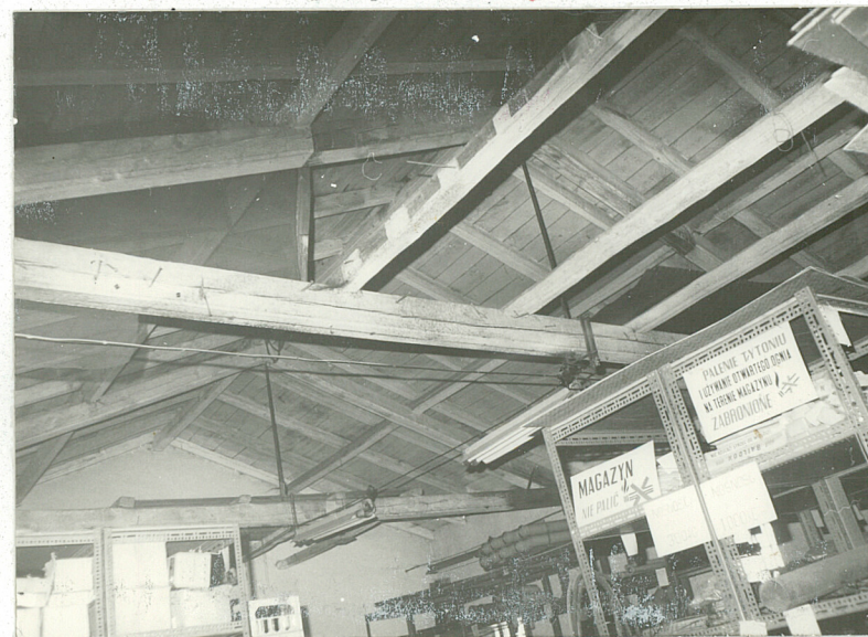
3. Szczyt północny. 5. Wnętrze magazynu, więźba dachu.
