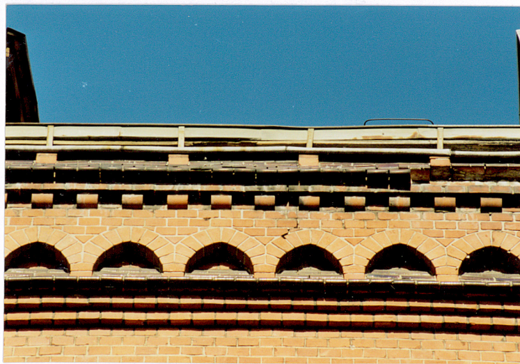
22. Gzyms podokapowy z fryzem arkadowym.
