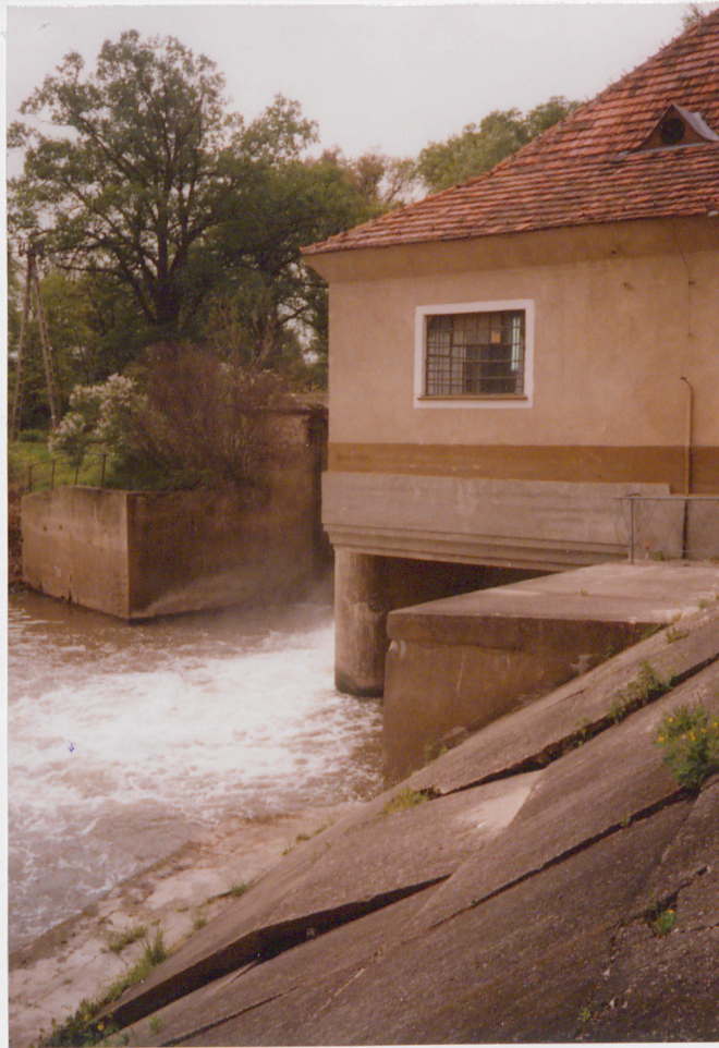
5. Stanowisko dolne - wylot z komór turbinowych i upustu jałowego, neg. 800/800/352/6
