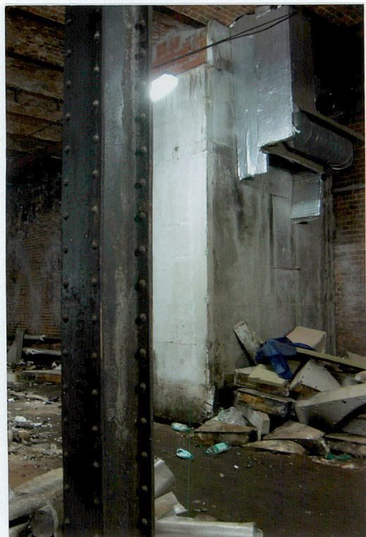
fot. 16. Żelazny filar w pomieszczeniu II kondygnacji części zachodniej.
