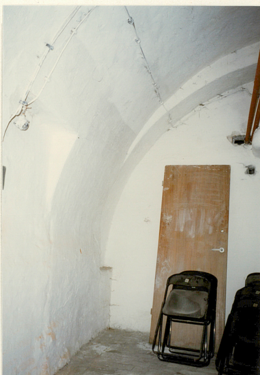
33. Pomieszczenie piwniczne sklepienie kolebką.
