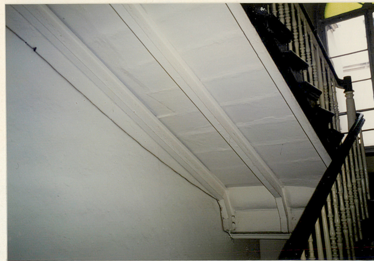
26. Konstrukcja krętej żeliwnej klatki schodowej.
