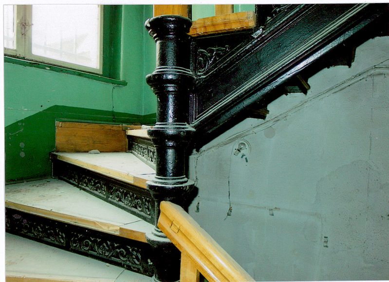
17. Słup konstrukcyjny schodów
