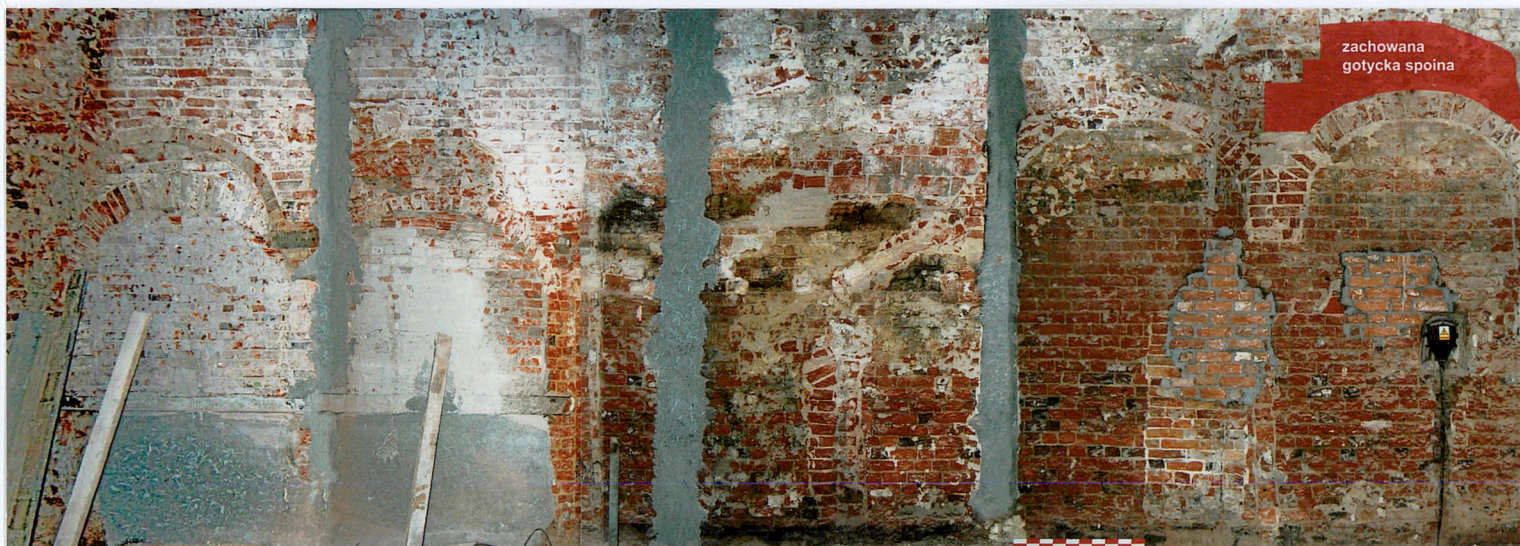
27. Ściana zachodnia z odsłoniętym wątkiem gotyckim.
