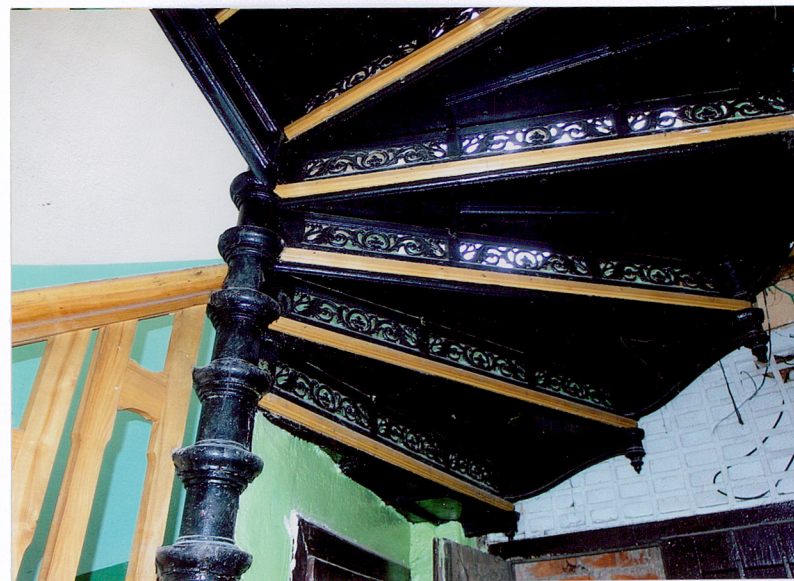
16. Wachlarzowy układ schodów między I i II kondygnacją
