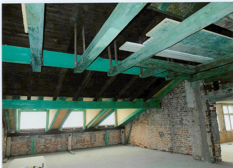
25. Strych, więźba dachowa (wzmocniona nową konstrukcją)
