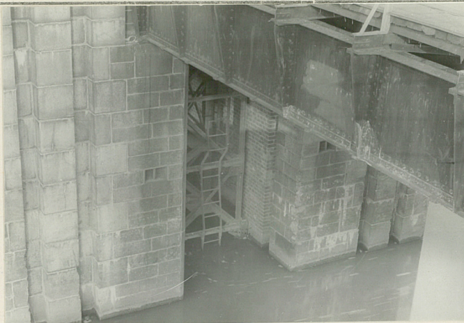
Wnęka wrót /wrota w pozycji "Otwarte"/, na pierwszym planie dźwigar prowadnicy wrót i kładki.
