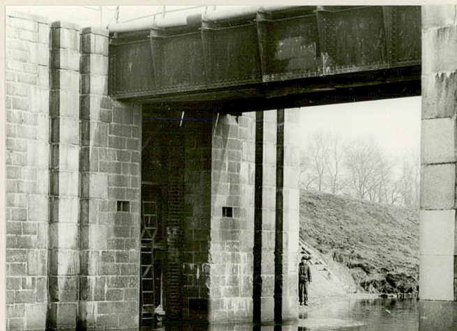
Dźwigary kładki dla pieszych i prowadnic wrót oraz wnętrza wrót - widok od dolnej wody.
