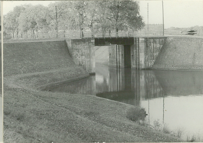
Widok od górnej wody - wrota w pozycji "Otwarte" /schowane we wnęce prawego przyczółka/.
