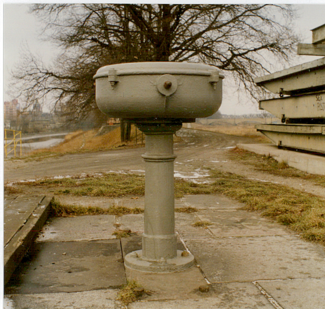
6. Ręczny mechanizm przekładniowy do otwierania bramy, neg. 400/213/1
