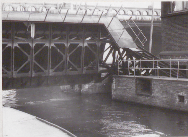
Głowa górna - zamknięcie segmentowe w momencie podnoszenia do pozycji "otwarte".
