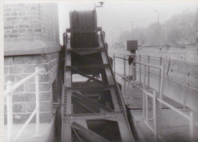
Głowa górna - lewe ramię zamknięcia segmentowego, widoczna przeciwwaga.
