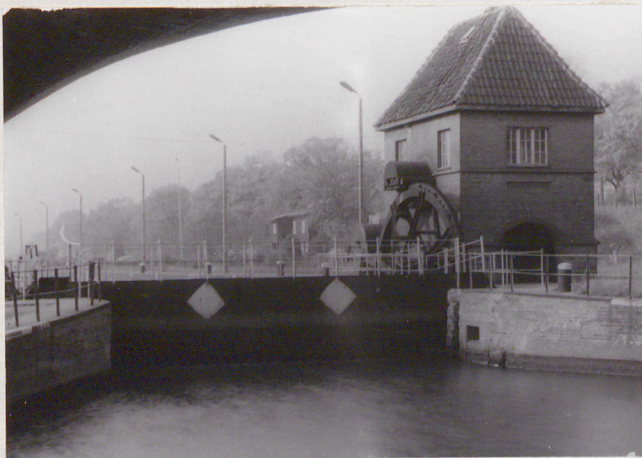
Głowa górna - widok od górnej wody, segment w pozycji "zamknięte".
