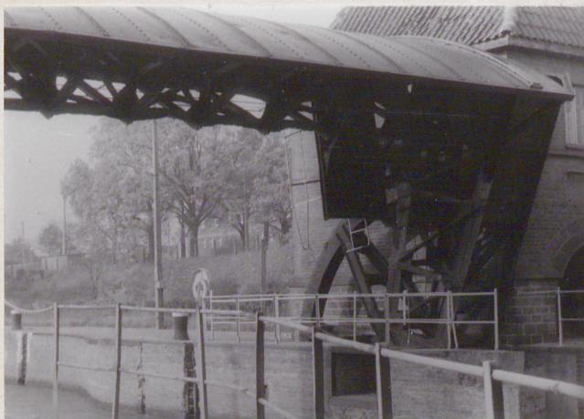
Głowa górna - widok od strony komory, zamknięcie segmentowe w pozycji górnej "otwarte".
