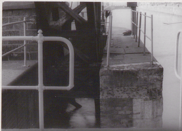
Głowa górna - kanał ramienia zamknięcia segmentowego w przyczółku lewym, zamknięcie podniesione.
