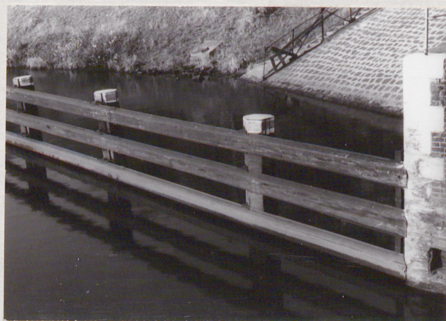
Stalowe kierownice dla zestawów pchanych w dolnym awanporcie.
