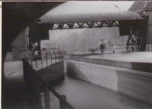
Głowa górna - widok od strony górnego awanportu. Segmentowe zamknięcie podniesione /śluzo- wanie zestawu pchanego/.
