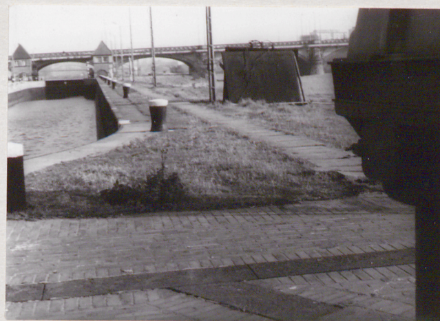
Lewy brzeg komory śluzy - widok od strony głowy dolnej. Na pierwszym planie fragment korony głowy z pokrywami kanałów.
