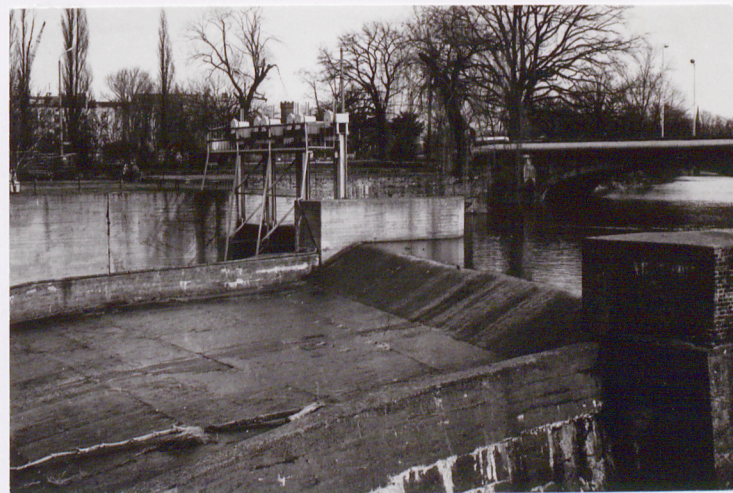
6. Widok od pld. zach. na próg jazu stałego, w głębi upust północny, neg. 400338/1.
