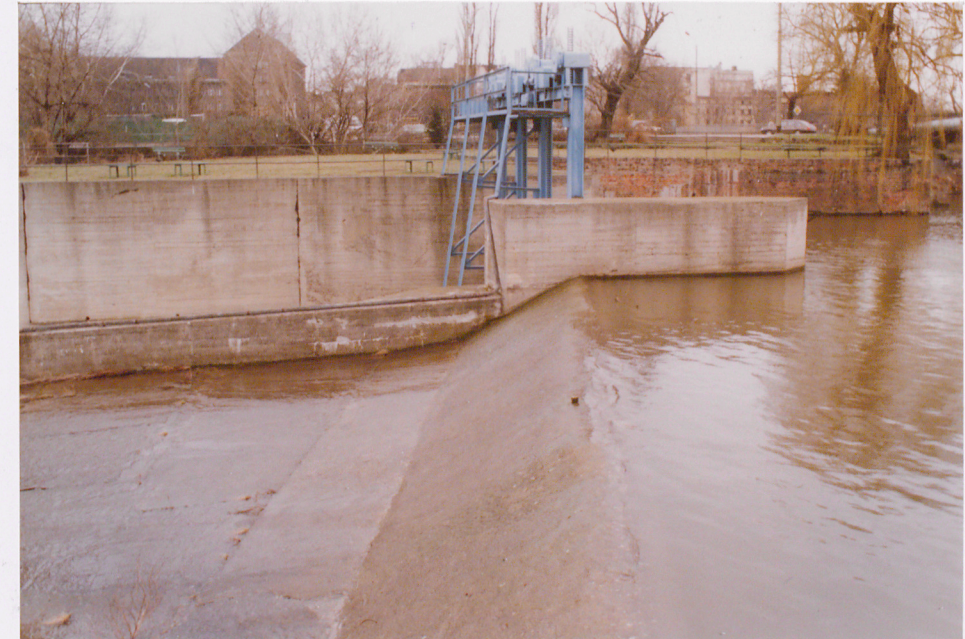
7. Górny próg jazu stałego, w głębi upust ulgi, neg. 400/300/4.
