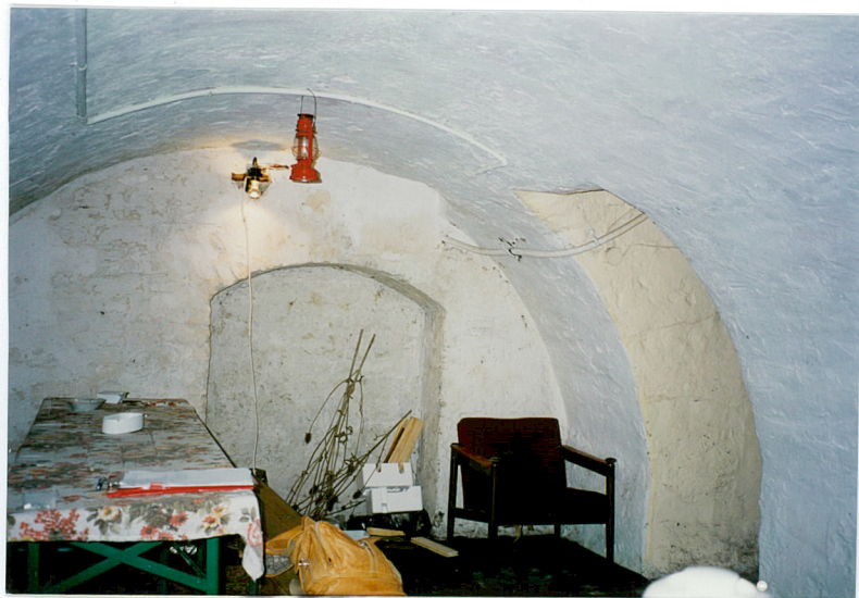
Sklepienie kolebkowe w piwnicy pod kamienicą.
