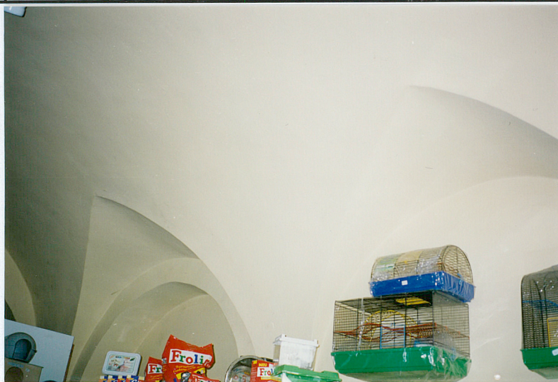
Sklepienie kolebkowe z lunetami w przyziemiu kamienicy.
