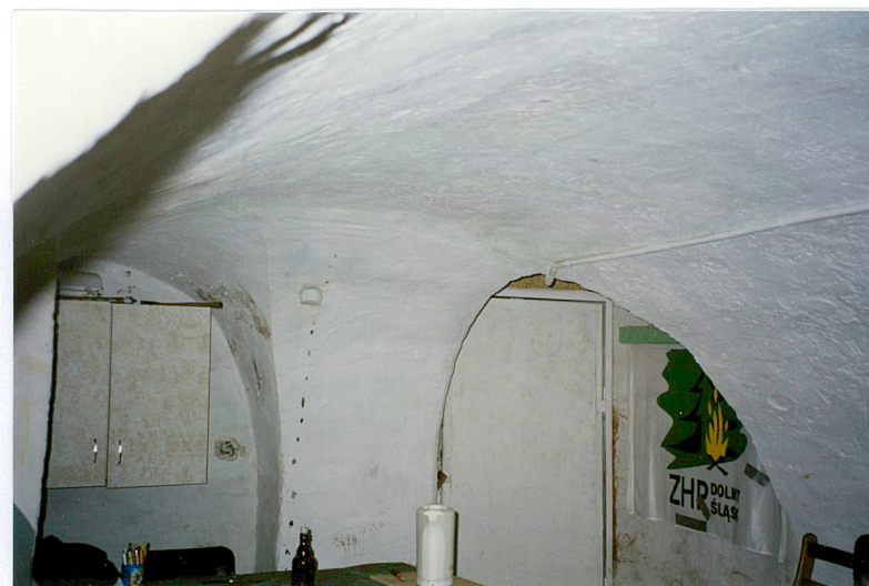
Sklepienie kolebkowe w piwnicy pod kamienicą.
