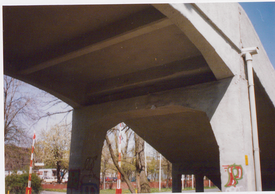
Podpora przy przejściu pomostu w biegi schodowe, neg. 800/317/4
