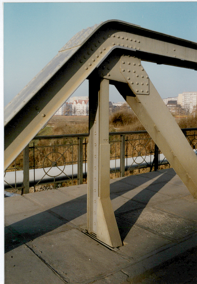
5. Skrajny węzeł dźwigara kratowego, neg. 500/641/5
