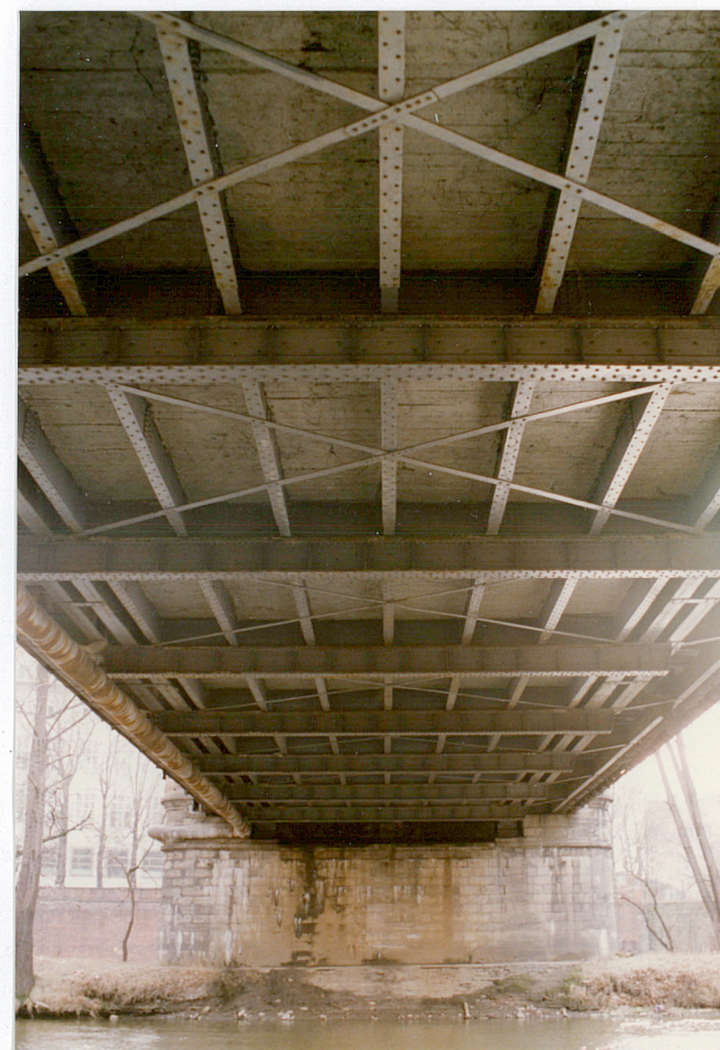
13. Pomost od dołu, poprzecznice i podłużnice, 400/301/2
