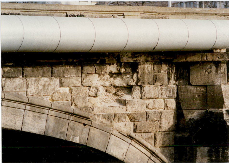
4. Wyrwa w murze czołowym i spękany pilaster, neg. 400/288/6
