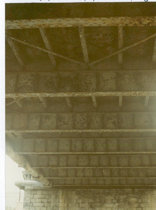
13. Konstrukcja pomostu, poprzecznicę i podłużnicę, neg. 400/99/2
