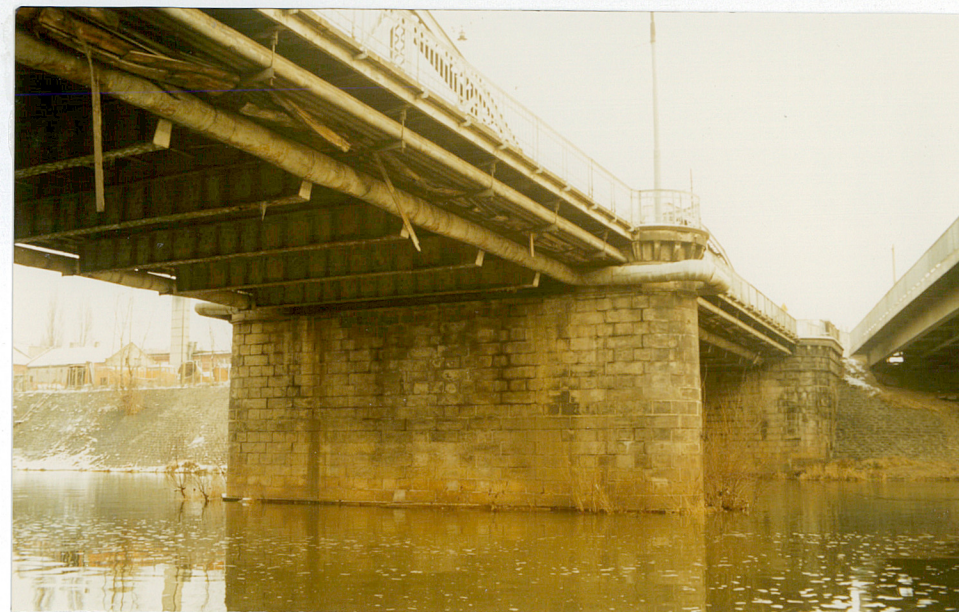
11. Filar i konstrukcja pomostu, poprzecznicę, neg. 400/98/2
