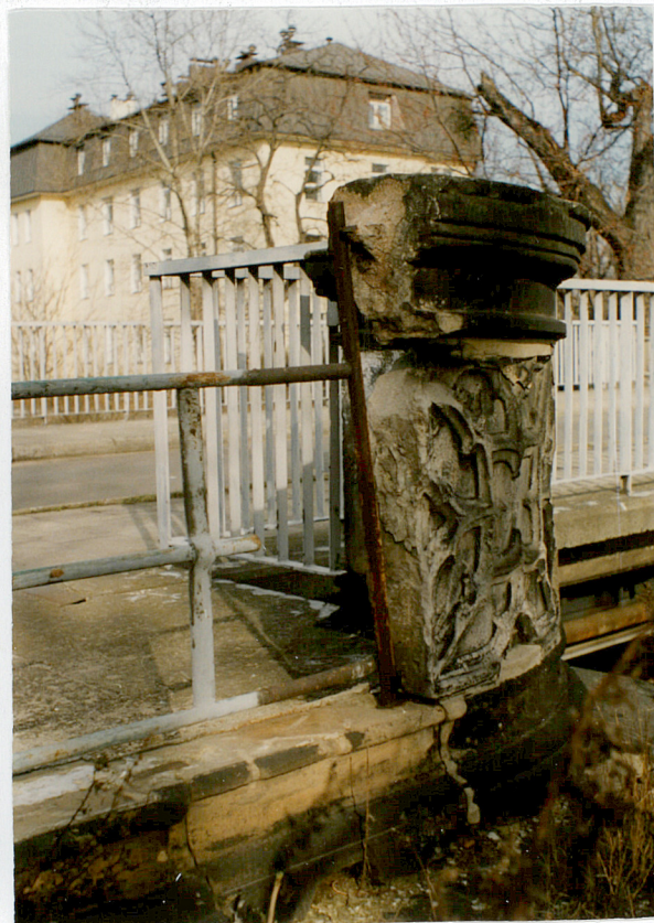
8. Uszkodzona bariera uzupełniona prowizorycznie, neg. 400/354/1
