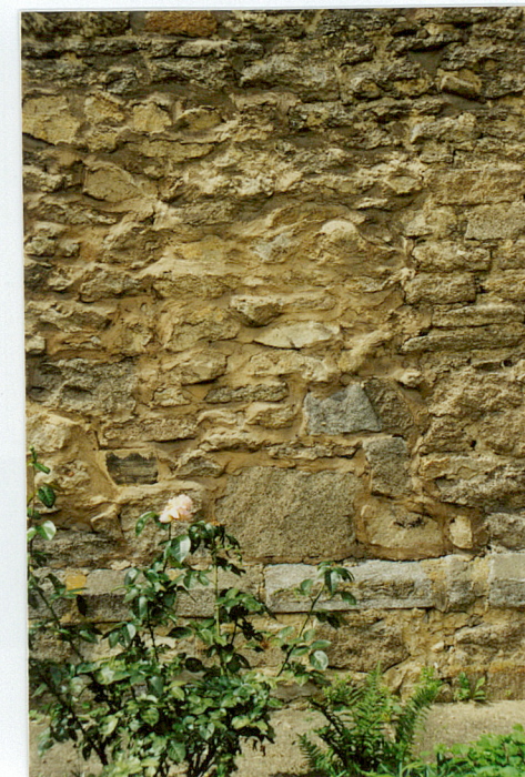
Fot. 14 Zamurowany otwór wejściowy we wschodniej ścianie prezbiterium
