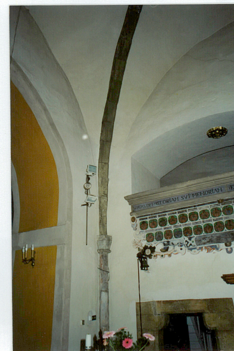
Fot. 24 Służka i żebro sklepienne
