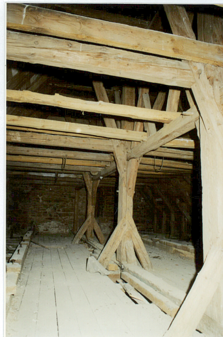
Fot. 27 Konstrukcja więźby dachowej
