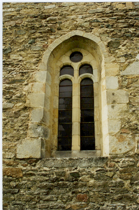
Fot. 16 Maswerk wschodniego okna prezbiterium
