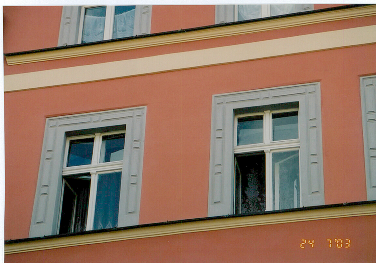
Fasada, piaskowcowe obramienia i stolarka okien
