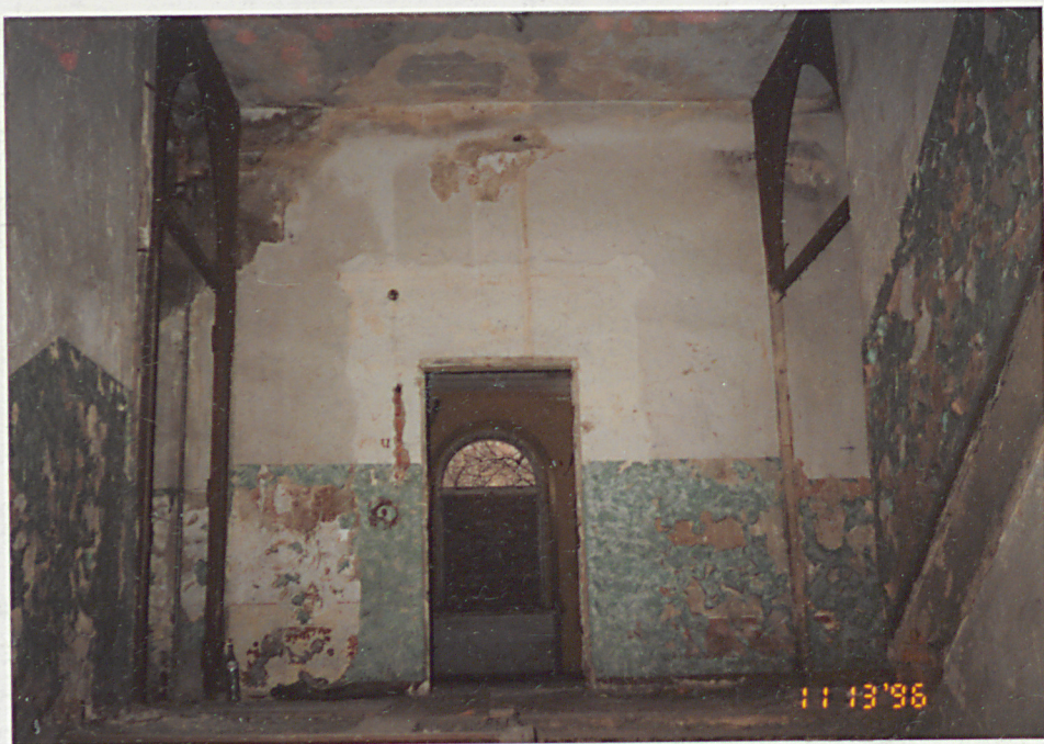
Korytarz na I p. - widok w kier. sali spotkań tow.- wyraźny ślad d.otworu drzwiowego
