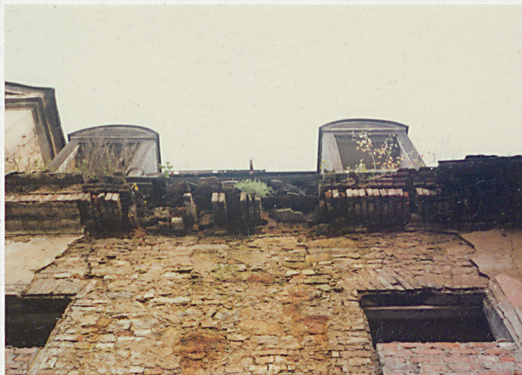
Zniszczony gzyms wieńczący-ściana tylna
