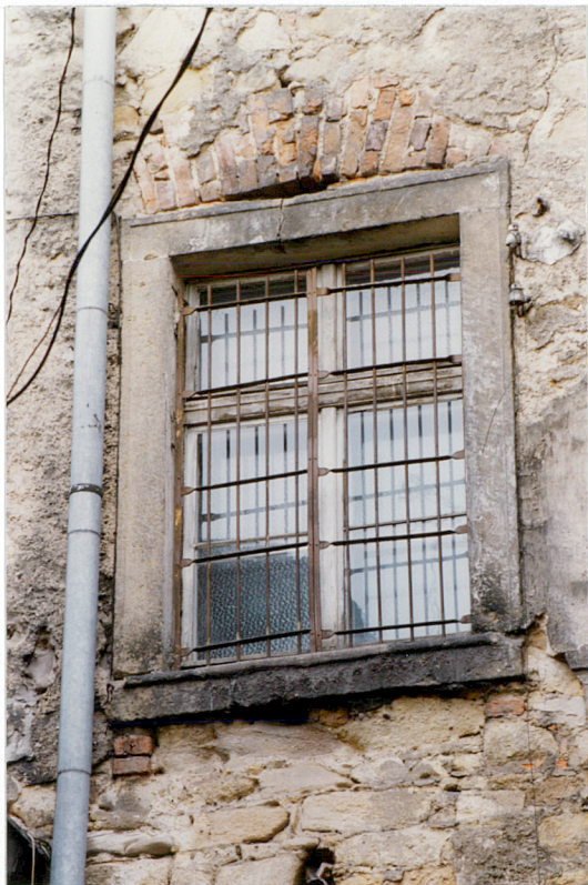
18. Kamienne obramienie okienne i struktura muru.
