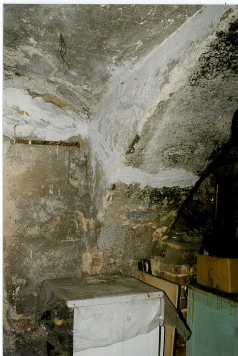
18. Fragment gurtu sklepienia piwnicy.
