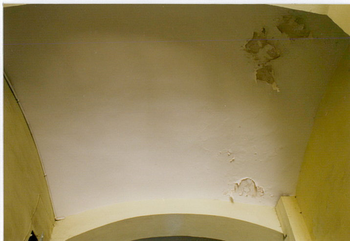
20. Sień, sklepienie żaglaste.
