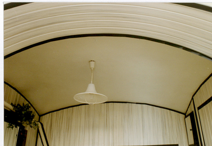
21. Zakład fryzjerski, sklepienie żaglaste.
