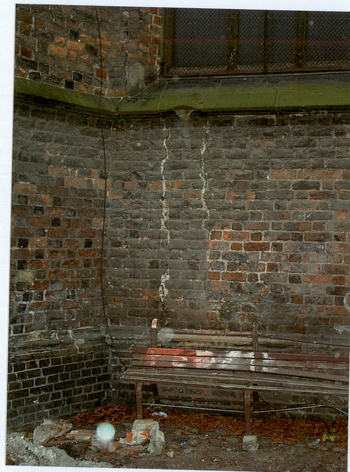
fot. 23 Spękania ściany północnego ramienia transeptu
