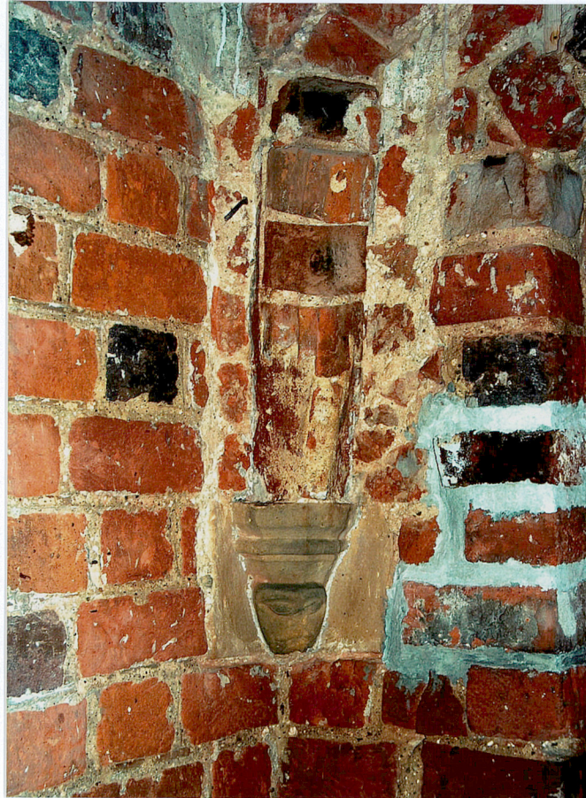
fot. 30 Wspornik żebra sklepienia sali w wieży
