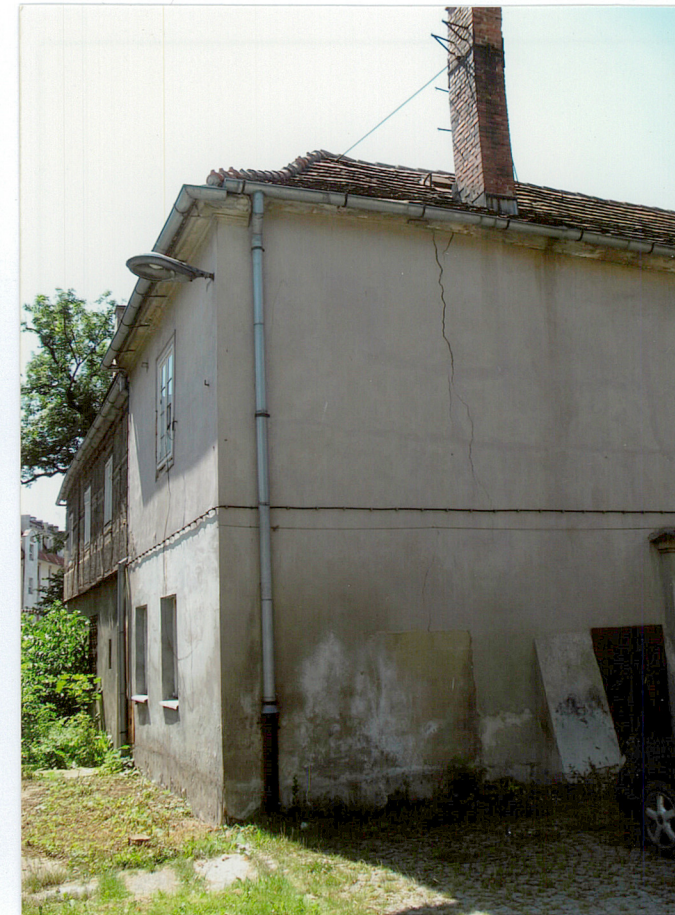
fot. 10. Narożnik łącznika z widocznym pęknięciem ściany.
