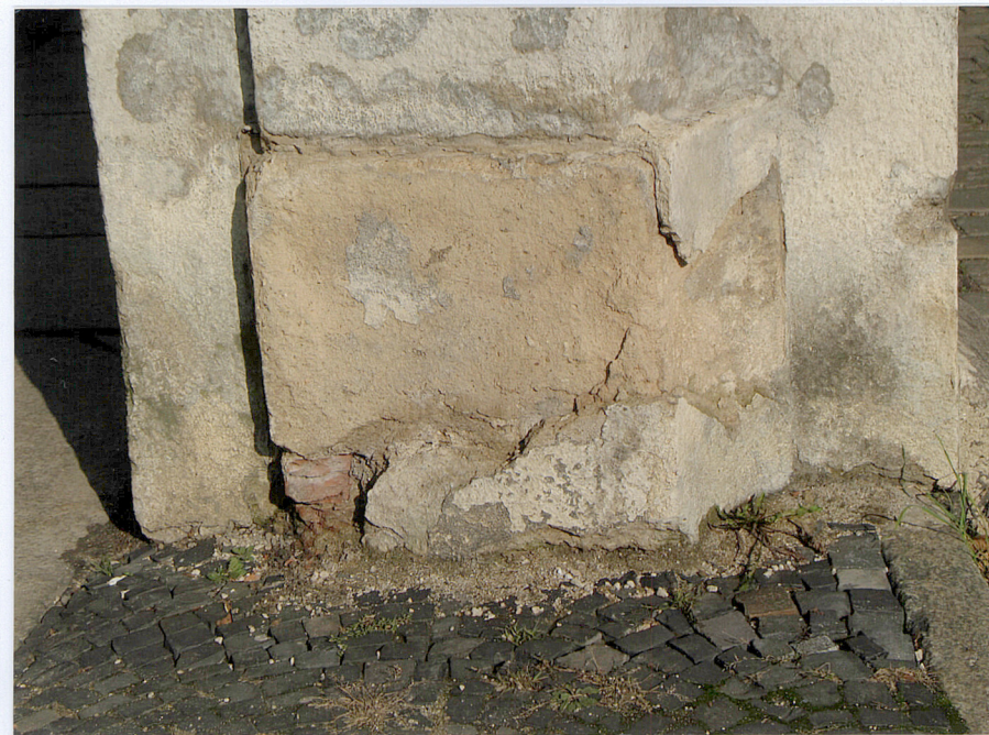
fot. 7. Uszkodzenia w partii cokołu bramy głównej.
