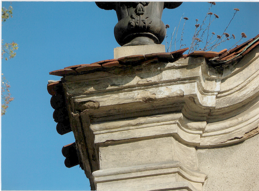
fot. 5. Uszkodzenia belkowania bramy głównej.
