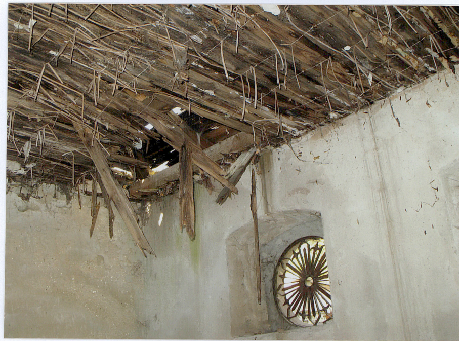
fot. 14. Kaplica (c), zniszczony strop.
