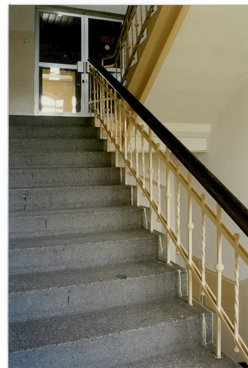
45. Wsch. klatka schodowa, granitowe stopnie i kuta, stalowa balustrada.
