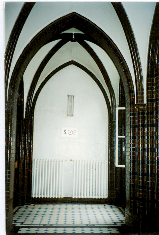
19. Sklepienia krzyżowe głównej klatki schodowej budynku A.
